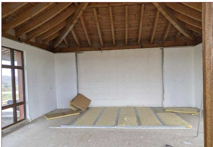
Le reliquaire en cours de travaux
